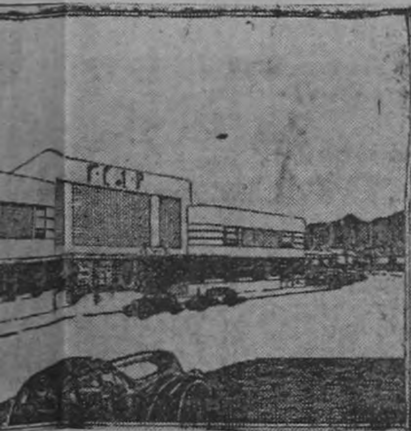
Estación Central en San José.
